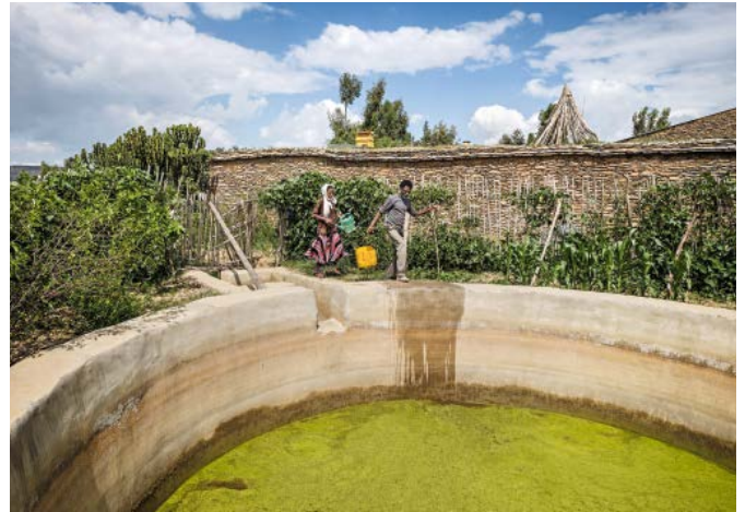
Le tapis d'algues à la surface du bassin réduit l'évaporation de l'eau.
