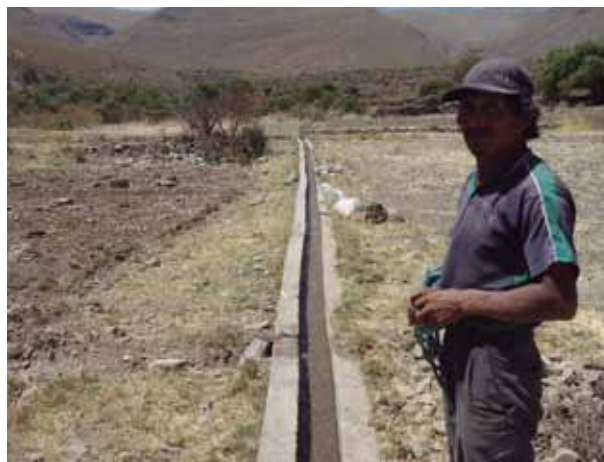
Foto 7: Construcción de canales de riego secundarios y terciarios.
