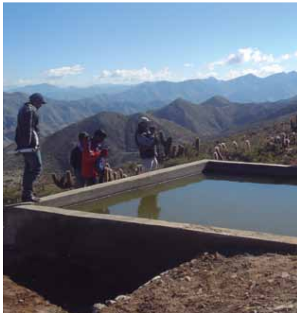
Foto 3: Construcción de estanques para mejorar la disponibilidad de agua.
