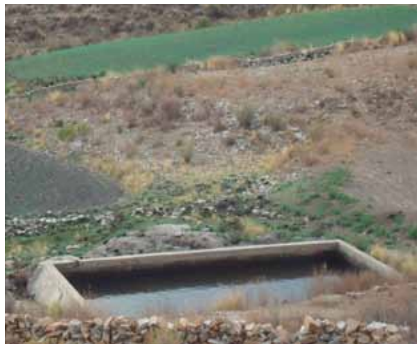
Foto 13: Estanque construido en la comunidad Huarmachi, El Puente.
