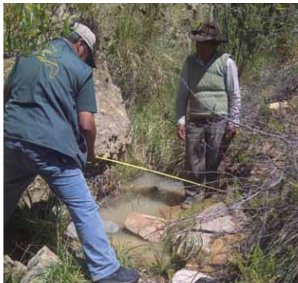
Foto 4: Comunarios realizando construcción de canales.
